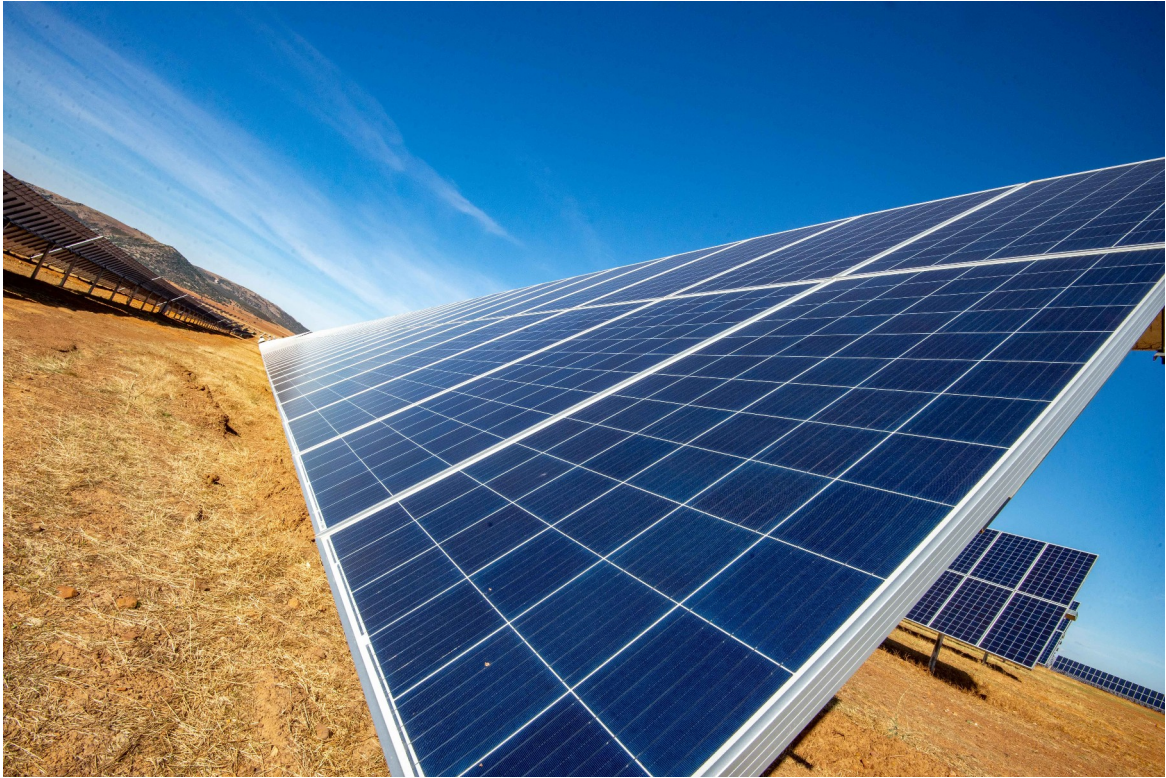
"Visita á planta de enerxía solar fotovoltaica, Picón I, II e III" (Emiliano García-Page Sánchez CCBY-SA 2.0)
