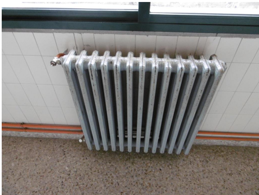
Imagen 13. Radiador de fundición
