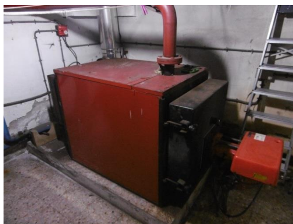
Termografía 29. Frontal de caldera de calefacción
