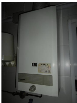
Imagen 17. Calentador de propano JUNKERS.
