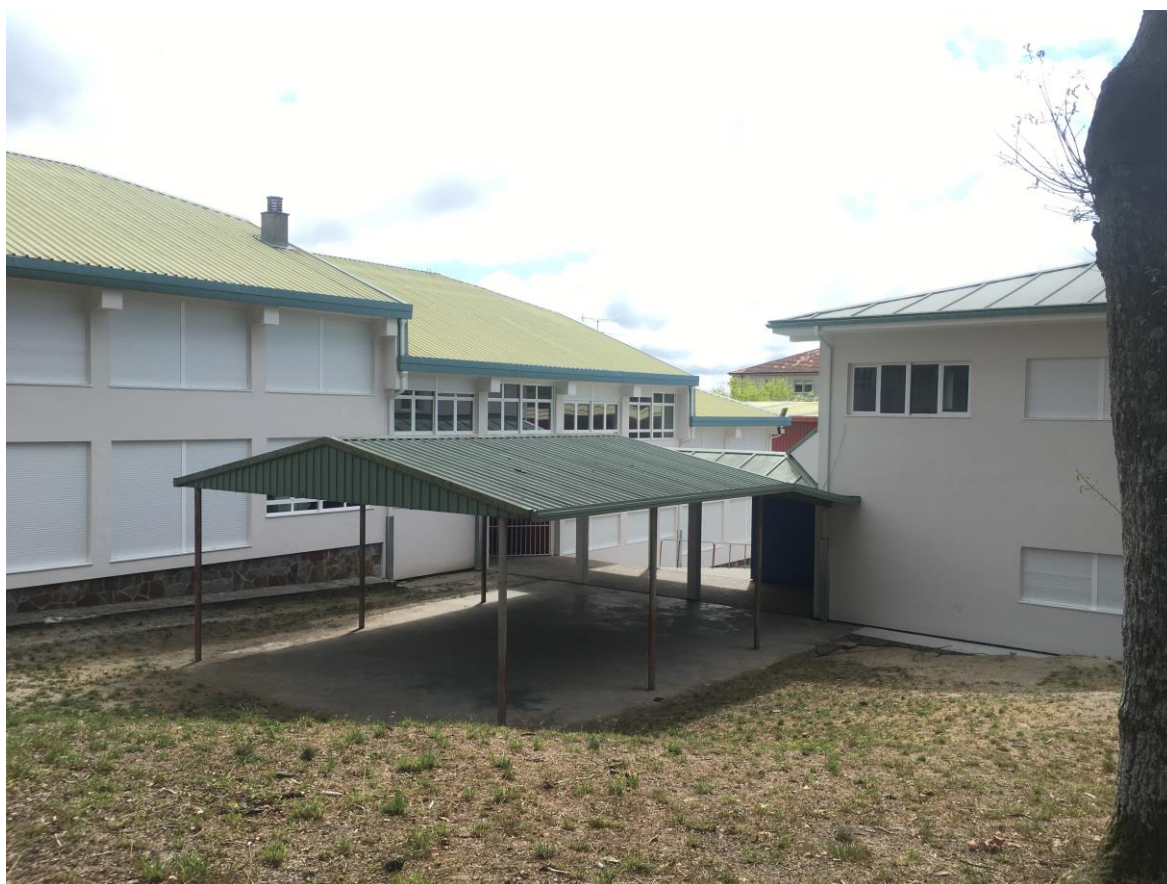
Imagen: cubrición a dos aguas con estructura metálica que se plantea demoler.
