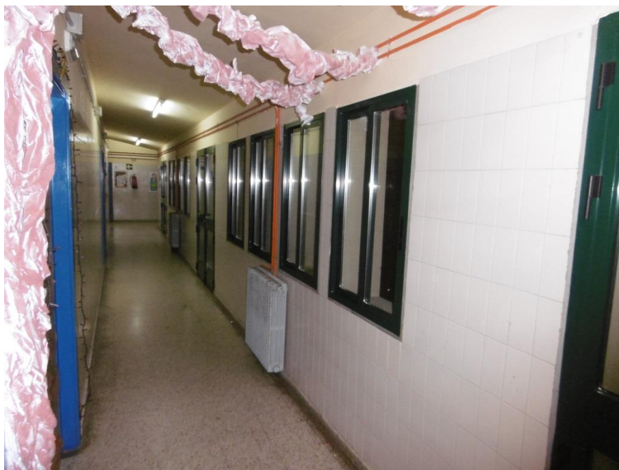
Imagen 12. Sistema de distribución de calefacción en superficie
