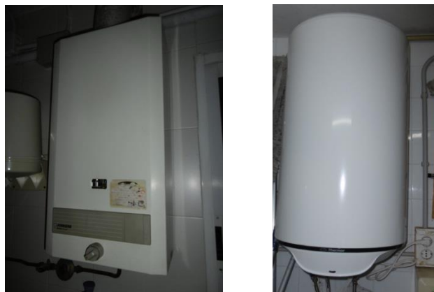
Imagen 25. Sistema de producción y almacenamiento de ACS
