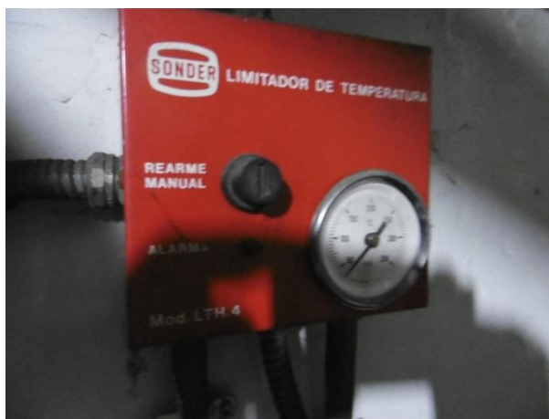
Imagen 16. Limitador de temperatura caldera de calefacción
