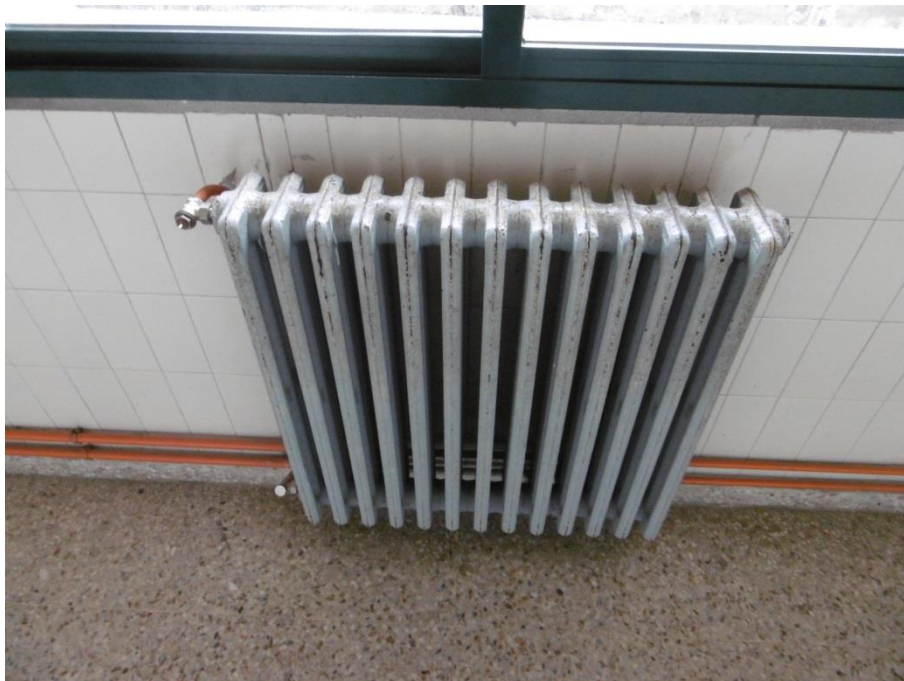
Imagen 13. Radiador de fundición
