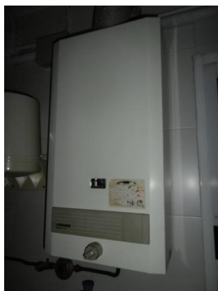
Imagen 17. Calentador de propano JUNKERS.
