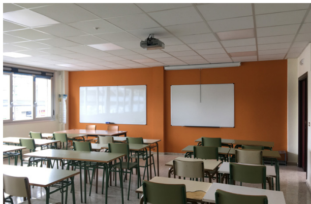
Fig. 22 Estado reformado aula con falso techo acústico.
