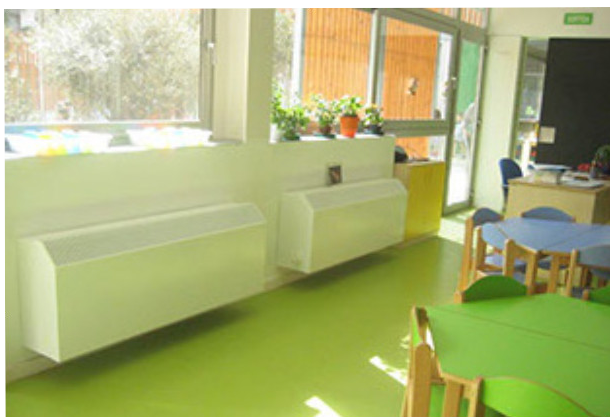
Fig. 13 Imaxe interior do CEIP Jaume I (Barcelona) co sistema de radiadores de admisión de aire.
