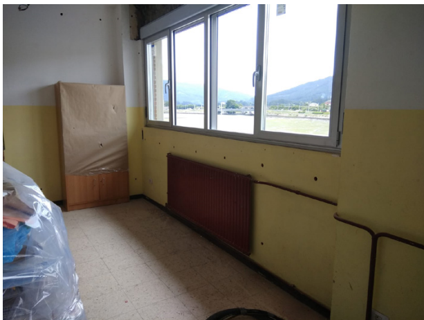
Fig. 15 Inxección de illamento en cámara (imaxe 1: perlas EPS en cámara. Imaxe 2: buracos interiores).
