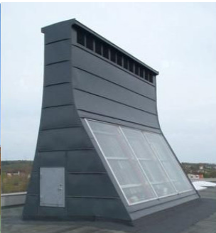
Fig. 05 Cheminea solar (zona con cristal e reixas)
