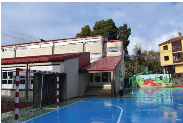
Faldón que ocasiona filtraciones en el interior
