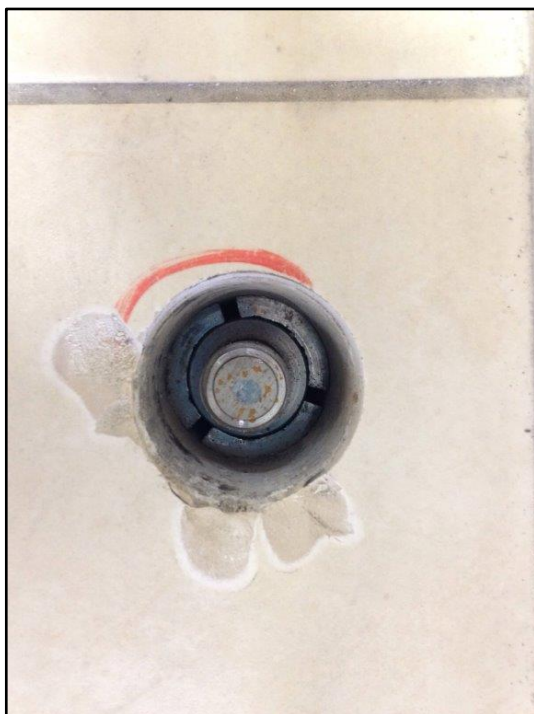
Imágenes n.º 4, 5, 6 y 7: Detalle del dispositivo de precarga fijo y su puesta en obra.
