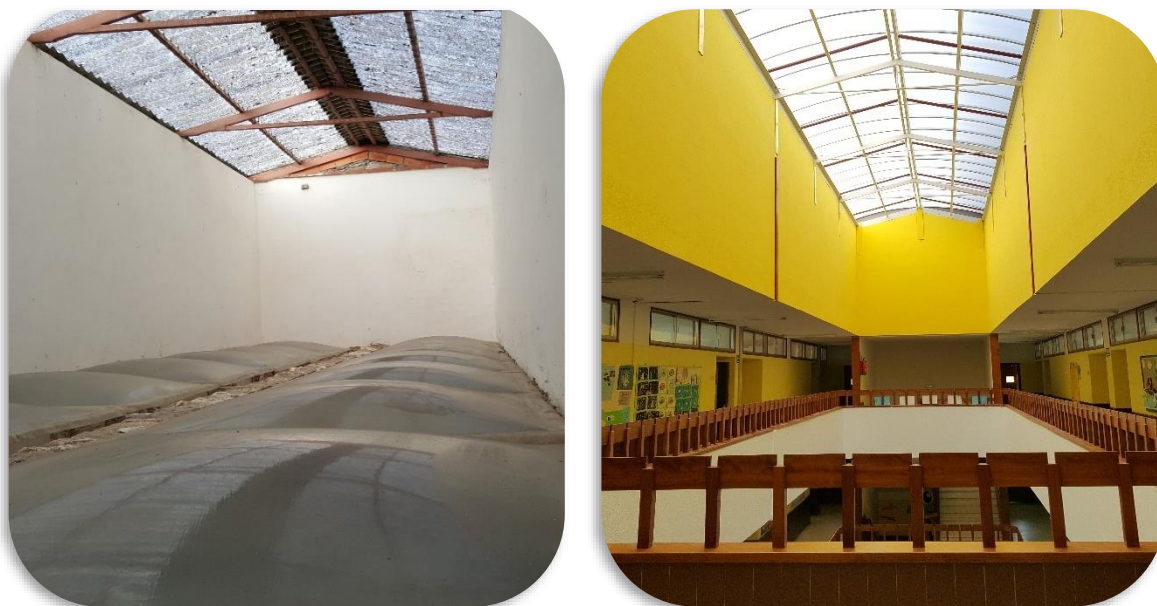
Figura 30 – Lucernarios en cubierta de diferentes tipos: cerrado (izq.) y abierto (der.)
