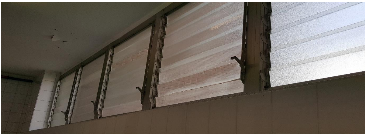
Figura 14 – Origen importante de infiltraciones de aire en la zona de baños.
