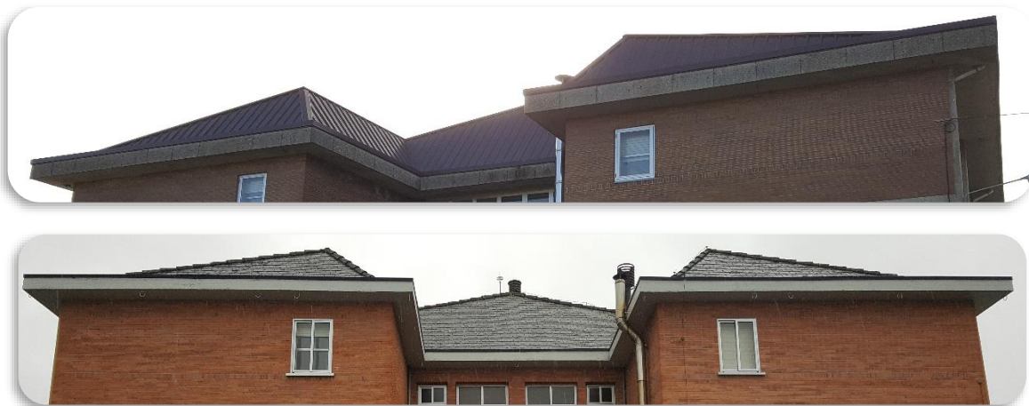
Figura 29 – Cubierta metálica en CEIP Albeiros (superior) y de pizarra en CEIP A Gándara (inferior).
