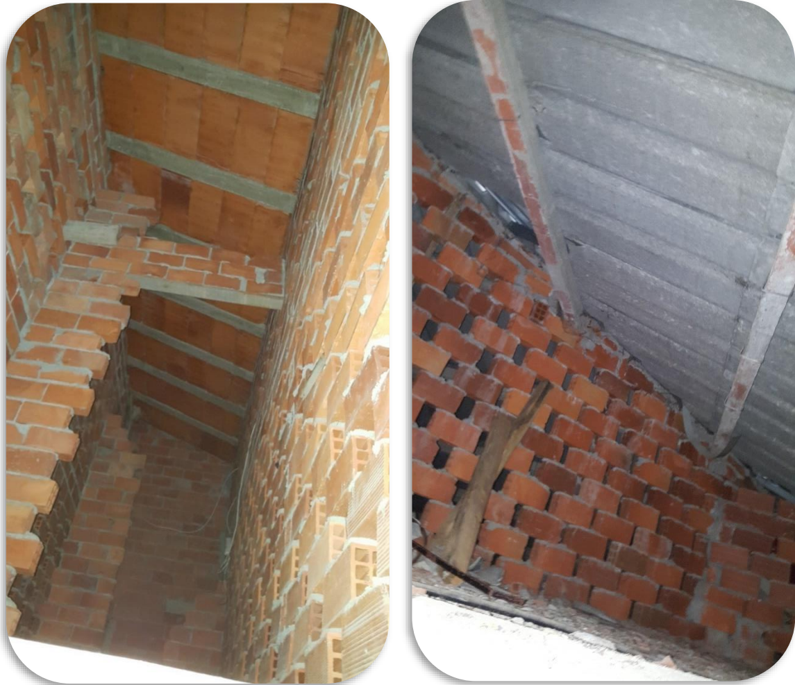
Figura 31 – Diferentes tipos de soportes de cubierta, y entramado de tabiques palomeros.
