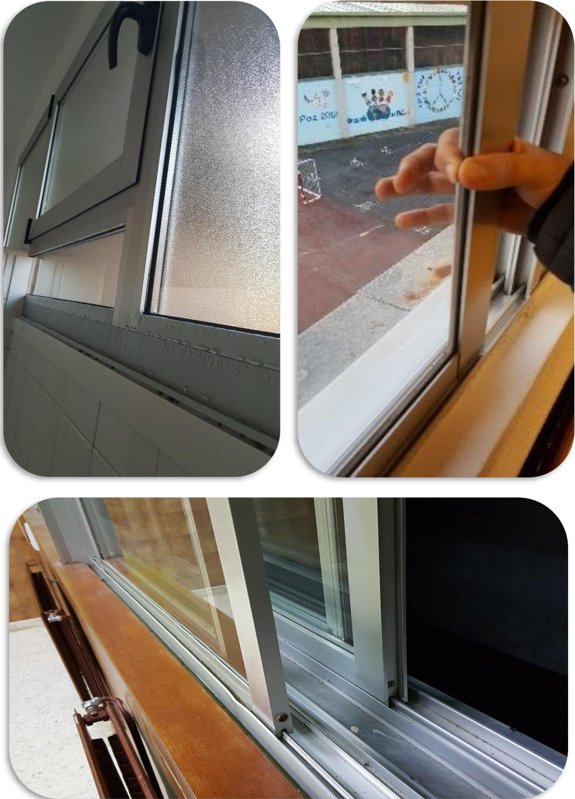
Figura 23 – Vidrio doble (izq.), simple (der.) y doble ventana (debajo). Carpintería metálica sin RPT.
