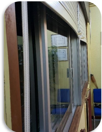
Figura 26 – Exterior de caja de persiana. Pandeo de hojas (der.) y cintas libres (izq.)
