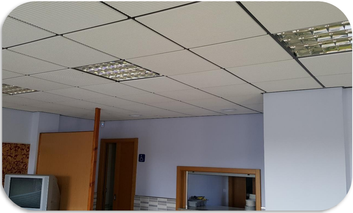
Figura 32 – Zona reformada en CEIP Albeiros, con falso techo y luminarias renovadas.
