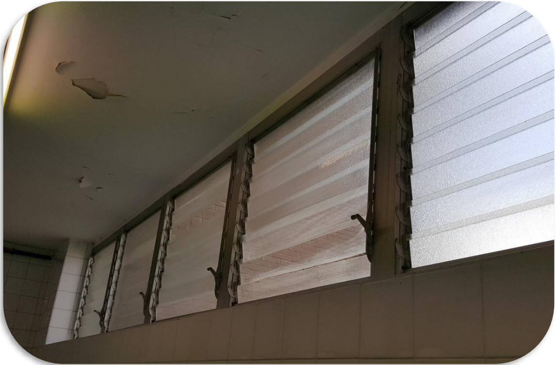
Figura 27 – Huevo en la envolvente con carpintería metálica sin RPT y lamas de vidrio.
