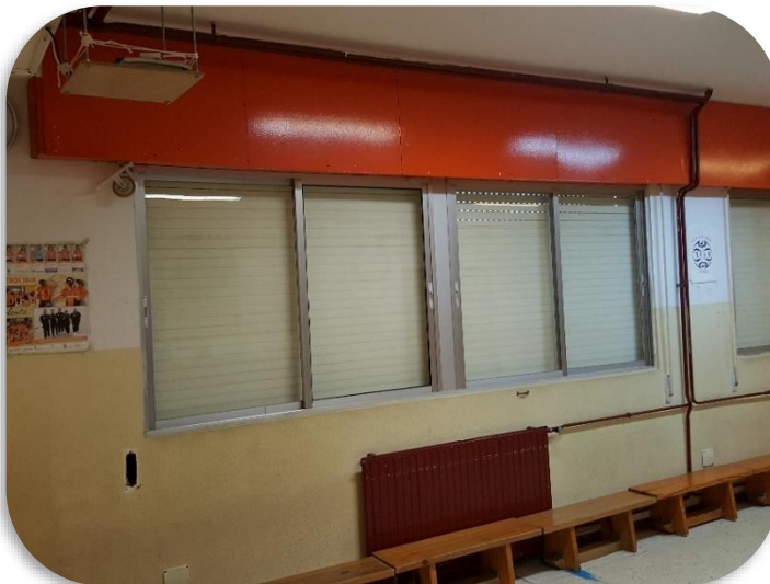
Figura 26 – Exterior de caja de persiana. Pandeo de hojas (der.) y cintas libres (izq.)
