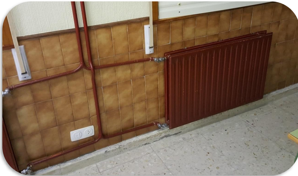
Figura 50 – Emisor de chapa ubicado bajo ventana.
