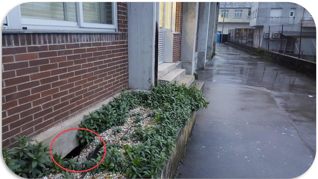
Figura 20 – Jardineras en la base, pilares, y agujero que da al forjado sanitario.
