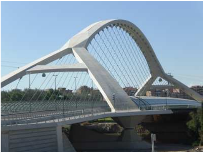
Nova ponte sobre o Ebro
