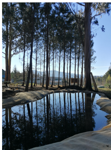
Figura 3, 4, 5, 6, 7 e 8. Secuencia de construción da charca na leira de prácticas do IES Antón Alonso Ríos. Retroescavadora furando o terreo, buraco feito, extensión da lámina EPDM, fixación da lámina impermeable con terra e pedras, plantación de fentos ás beiras e resultado final coa tea de xuta natural extendida, respectivamente. Fotos: Fernando Reigosa
