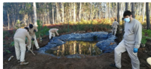
Figura 3, 4, 5, 6, 7 e 8. Secuencia de construción da charca na leira de prácticas do IES Antón Alonso Ríos. Retroescavadora furando o terreo, buraco feito, extensión da lámina EPDM, fixación da lámina impermeable con terra e pedras, plantación de fentos ás beiras e resultado final coa tea de xuta natural extendida, respectivamente. Fotos: Fernando Reigosa
