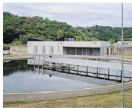
Nueva planta depuradora de aguas residuales en LUGO. ALBERTO LÓPEZ
