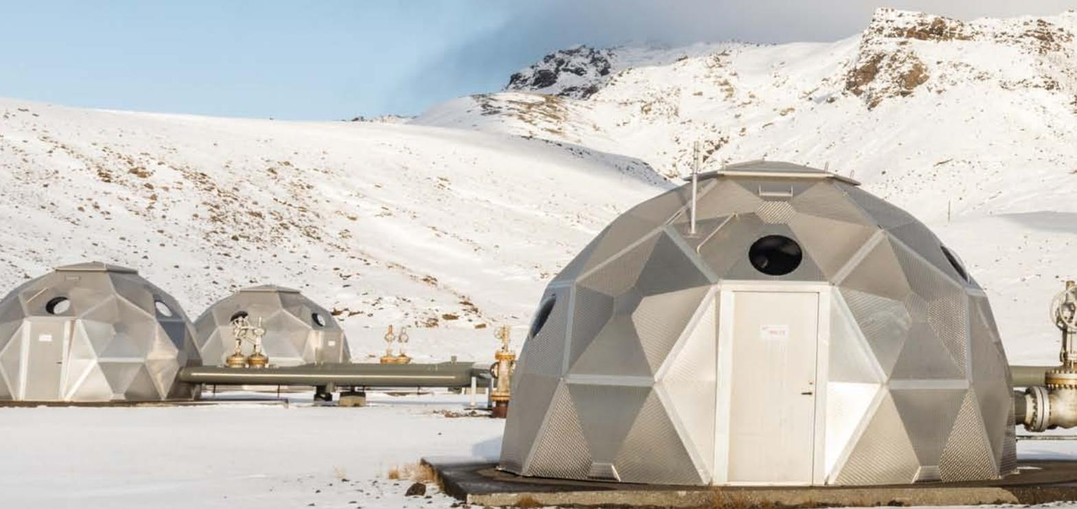
EN LA CENTRAL GEOTÉRMICA de Hellisheiði, en Islandia, unos pozos de inyección introducen en el sustrato rocoso profundo una solución salina junto con dióxido de carbono extraído del aire.
