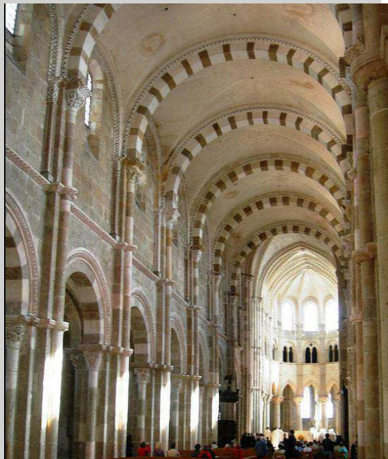
Imagen 14: Interior de S a M a de Vezelay. Licencia Creative Commons.
