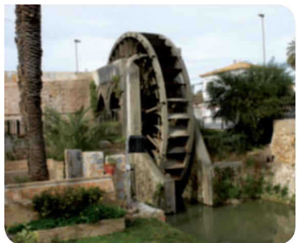
Nora de Alcantarilla (Murcia).
