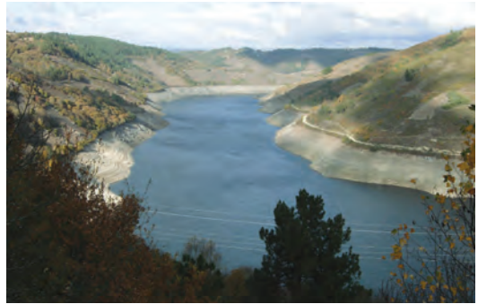
Encoro Belesar creado en 1963 para abastecer unha central hidroeléctrica.
