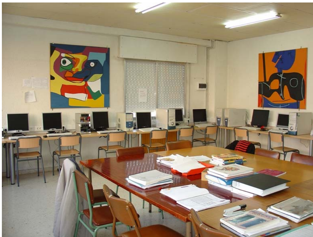
Figura 3: Vista da sala do profesorado coa canaleta con tomas eléctricas e de datos ó longo das mesas.
