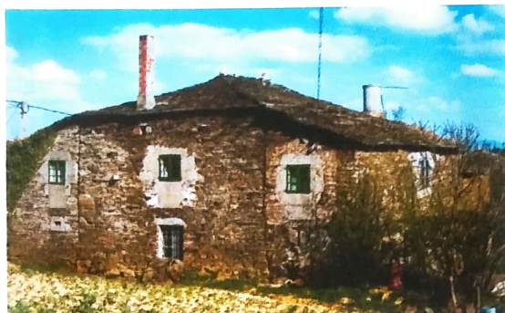
Estado actual da torre
