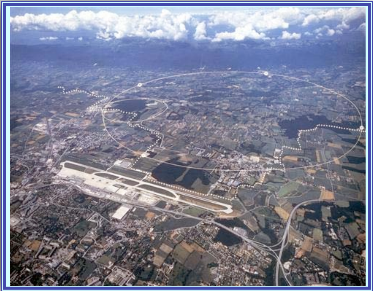
Vista aérea do CERN. O círculo grande mostra a liña do túnel do LHC de 27 km. A liña de cruces indica a fronteira entre Francia e Suíza
