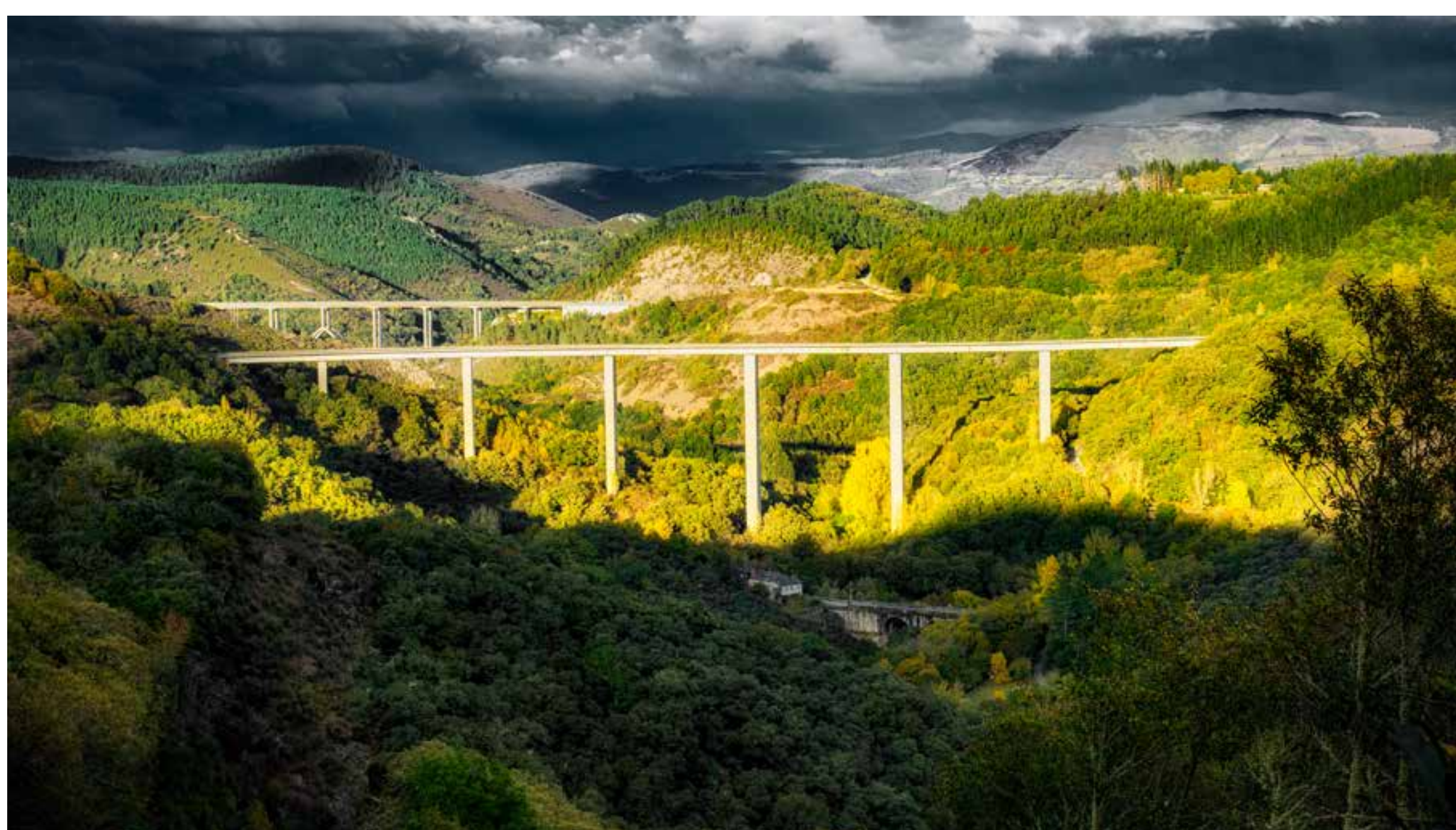
Vista de los tres puentes © viamagicæ
