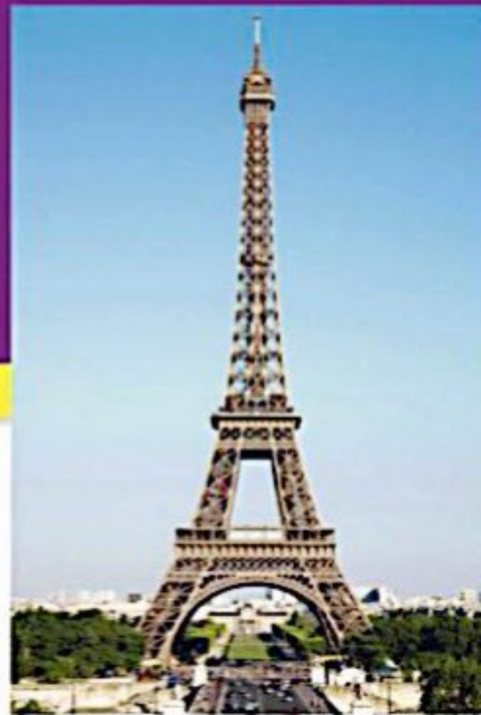
A Torre Eiffel de París é unha grande estrutura de ferro que se apoia sobre catro piares de cemento.
