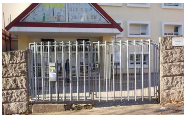
ACCESO PRINCIPAL EDIFICIO A
