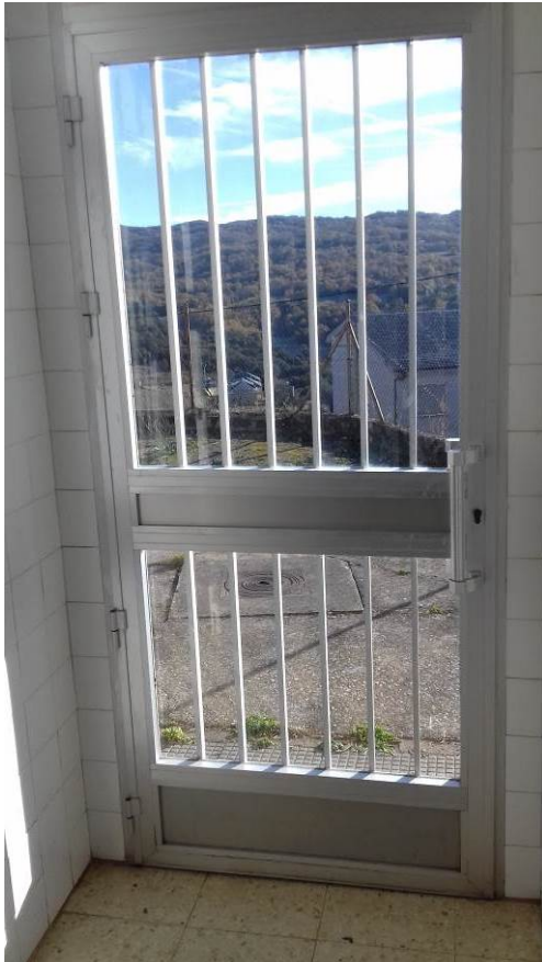
Acceso AE-04: Zona cocina
