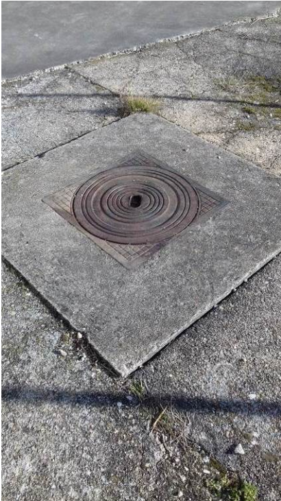
Detalle acceso tanque combustible
