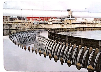
FILTRADO DEL AGUA POTABLE
