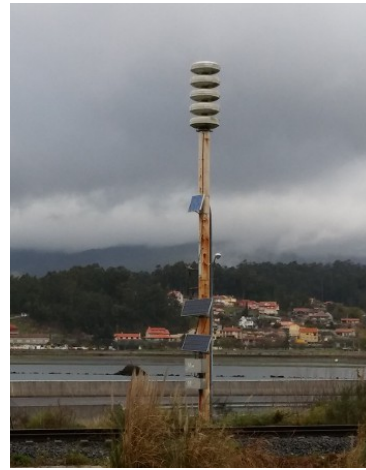
Paneis solares orientados e inclinados de forma diferente
