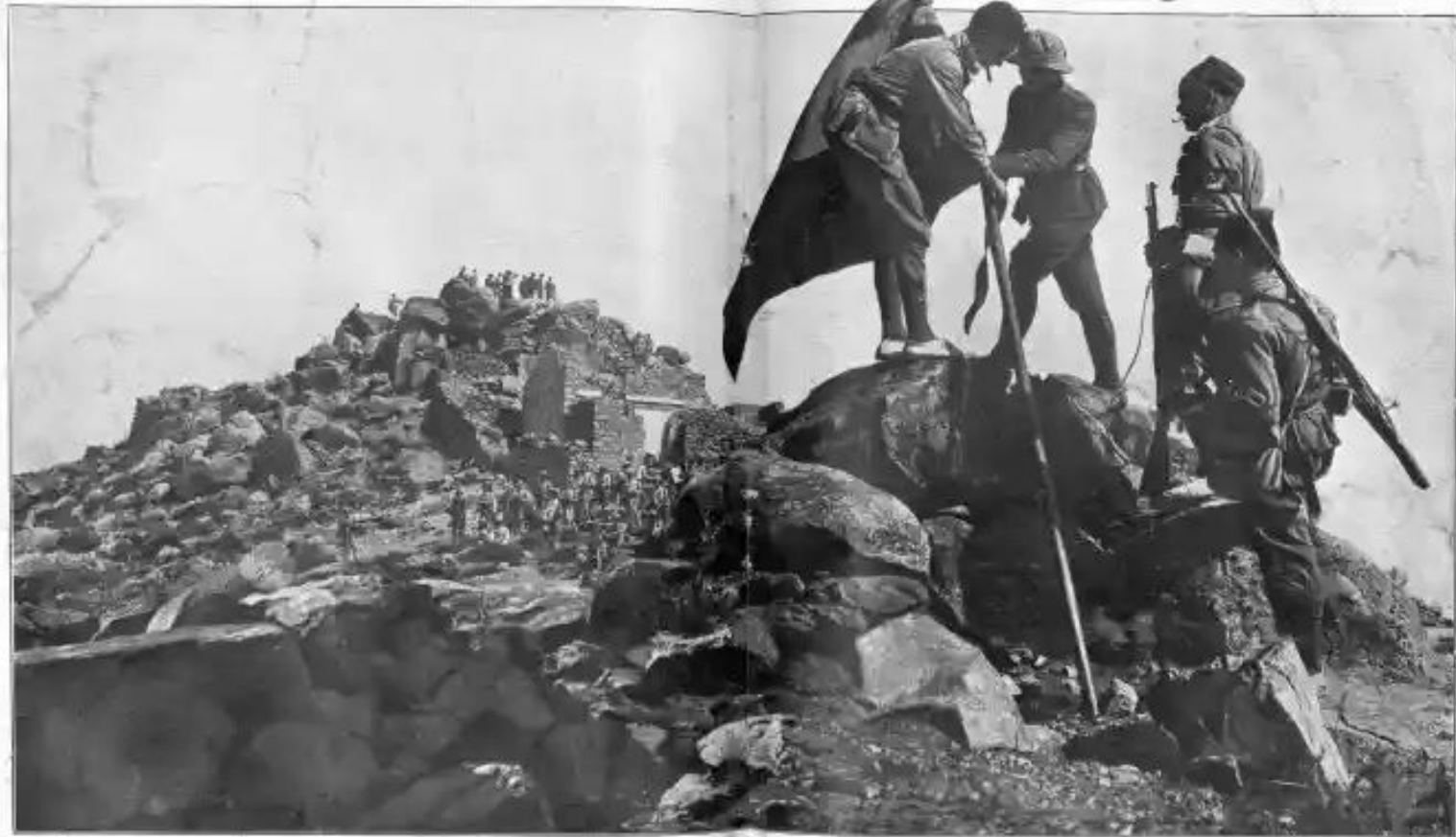
A las once y media del día 29 del mes de mayo, en la zona de Gurugú, se produjo la primera toma de terreno. Después de haber estado en el Gurugú, el primer punto que se tomó fue el punto que más tarde se llamó Gurugú. Este punto era un cerro que se encontraba en la zona de Gurugú. Este punto era un cerro que se encontraba en la zona de Gurugú. Este punto era un cerro que se encontraba en la zona de Gurugú.
