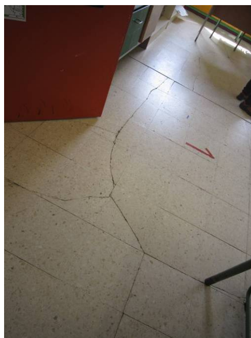
Rotura de pavimento por flexión de forjado
