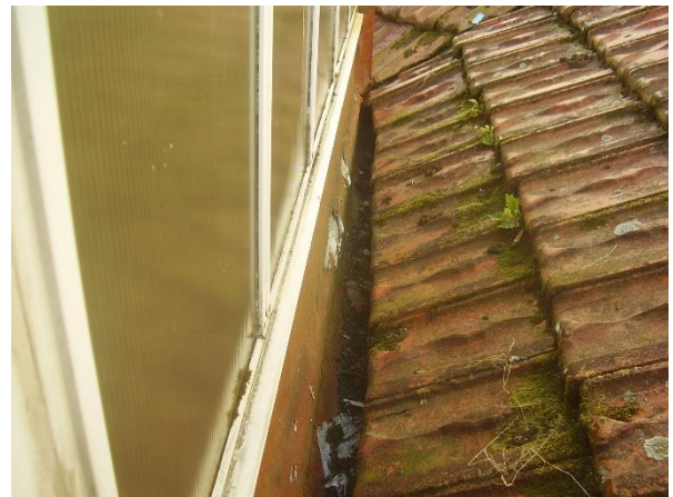
Detalle canalón oculto cubierta
