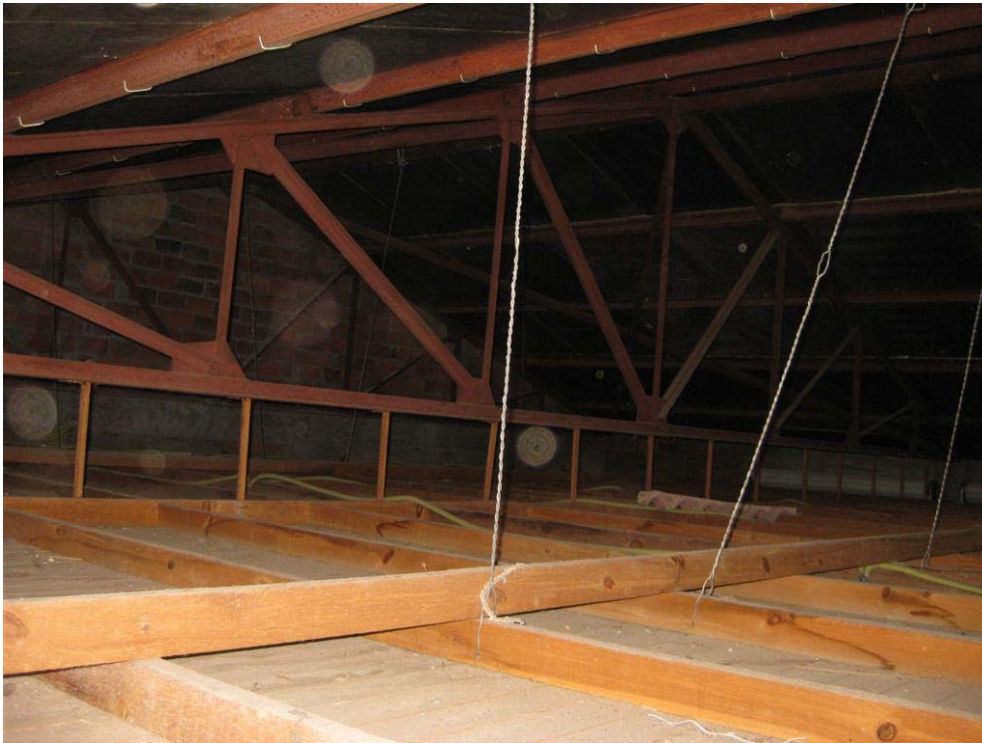
Vista del falso techo y estructura de cubierta
