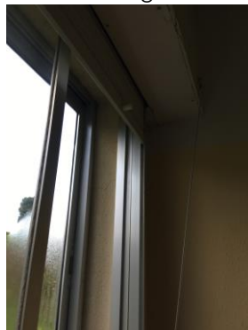
Ventana tipo. Alzado, capialzado y persiana con vierteaguas.
