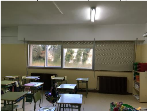
Ventana tipo. Alzado, capialzado y persiana con vierteaguas.
