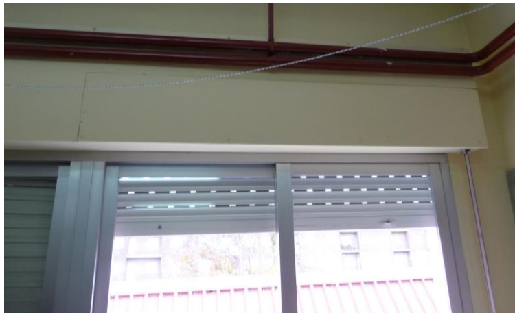
Detalles de carpintería simple de aluminio vidrio simple y detalle de caja de persiana con conducciones sobre ella que impiden su registro.
