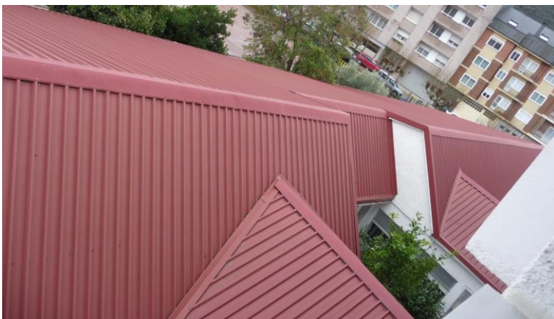
Vista general de cubierta y detalle de canalón de PVC con insuficiente vuelo sobre la cubierta que provoca un mal funcionamiento y un deficiente mantenimiento
