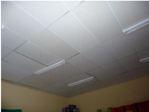
Detalle de uno de los falsos techos en los que se aprecia su mal estado y una de las cajas de persianas rotas
