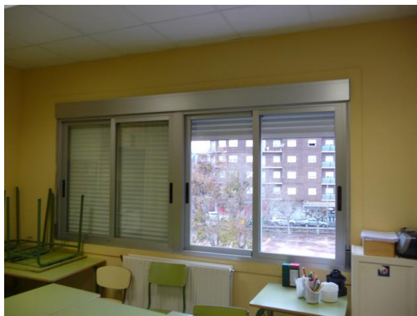
Vista interior de las ventanas de una hoja con carpintería de aluminio y doble acristalamiento de la zona ampliada de planta segunda a mantener
