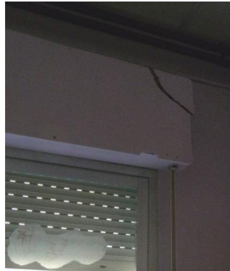
Detalle de uno de los falsos techos en los que se aprecia su mal estado y una de las cajas de persianas rotas
