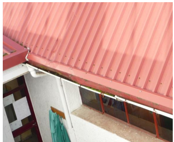
Vista general de cubierta y detalle de canalón de PVC con insuficiente vuelo sobre la cubierta que provoca un mal funcionamiento y un deficiente mantenimiento
