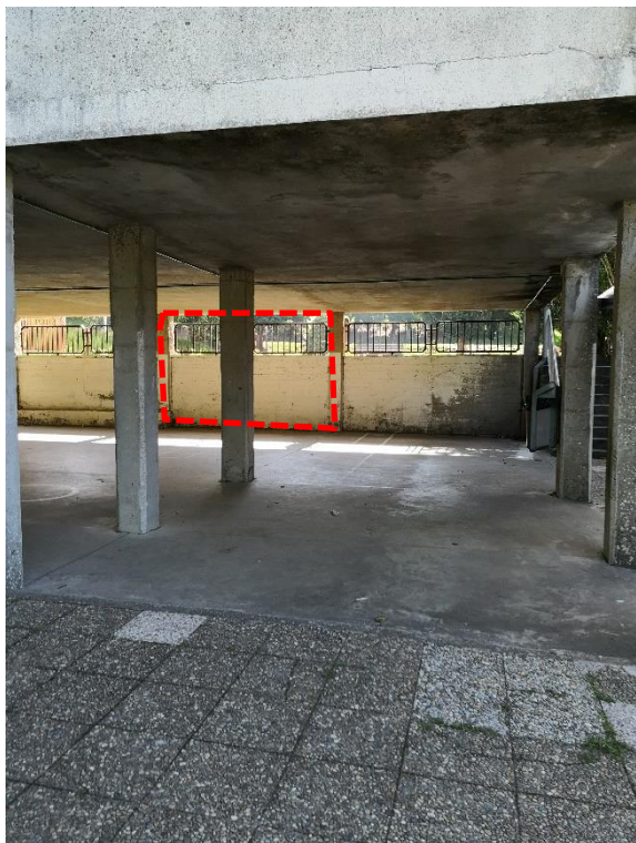
A la izquierda, apertura de hueco de acceso a nueva sala de calderas. A la derecha, apertura de hueco de conexión entre el edificio existente y el nuevo que se proyecta.
