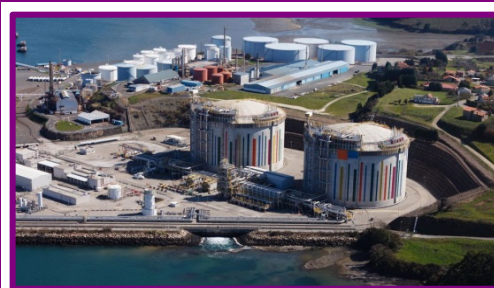
Depósitos de gas natural de Reganosa en Ferrol
