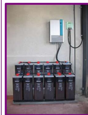
Batería para acumular la electricidad de las células fotovoltaicas
