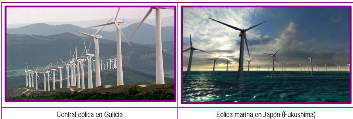
La baja densidad energética de la energía eólica por unidad de superficie en una determinada zona tiene como consecuencia la necesidad de proceder a la instalación de más máquinas para el aprovechamiento de los recursos disponibles. El ejemplo más común de una instalación eólica es el representado por los "parques eólicos" (colocación de varios aerogeneradores en una zona conectados a una única línea que los conecta a la red eléctrica).
