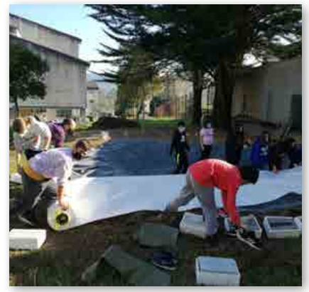
3. Cubrimos coa lona impermeable e co feltro protector.
