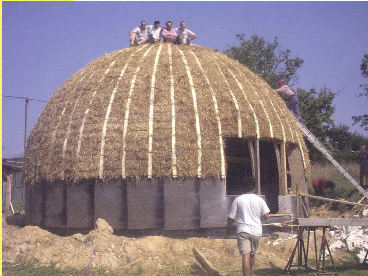
Estructura de madera laminada e cerramentos de balas de palla. Estudio de son. Forstmehren. Alemania. 2003
