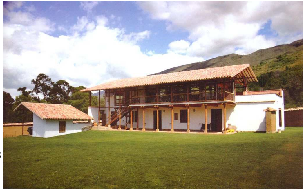
Tapial e adobe: Residencia “El Carmen”. Villa de Leiva. Colombia. 2006
