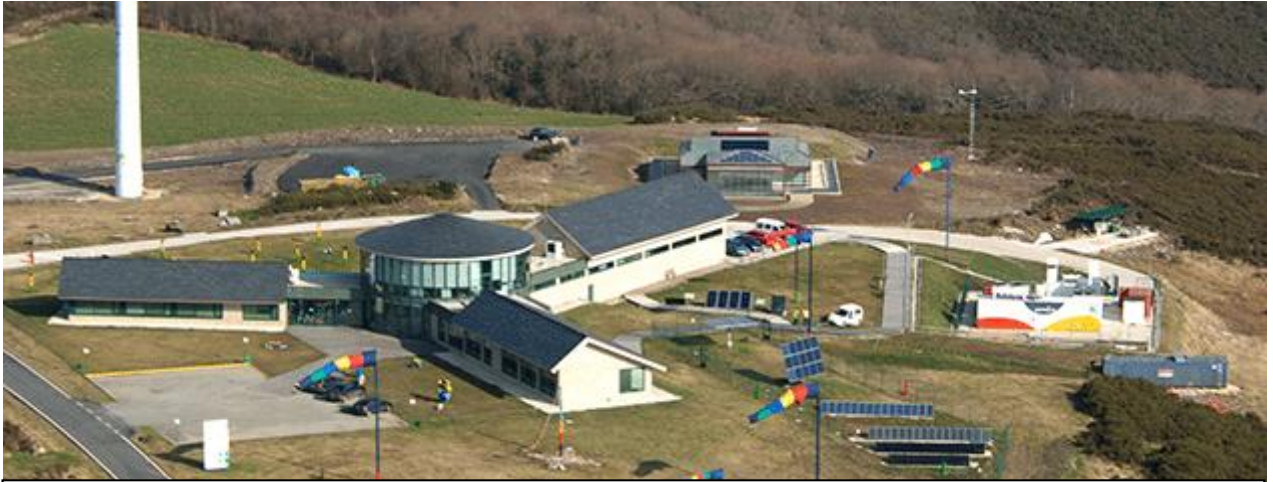
VISTA DO PARQUE EÓLICO
