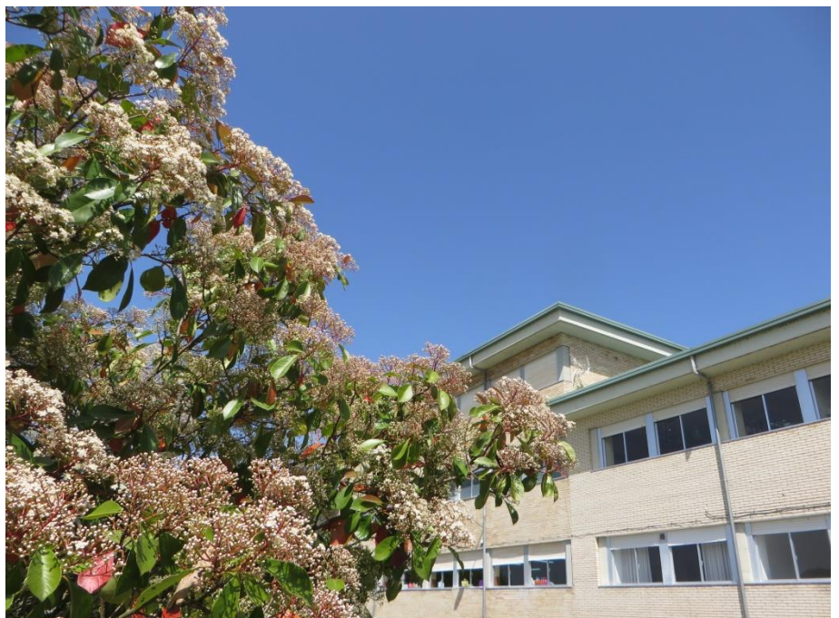
Vistas parciais do comedor escolar e da fachada sur do edificio principal
